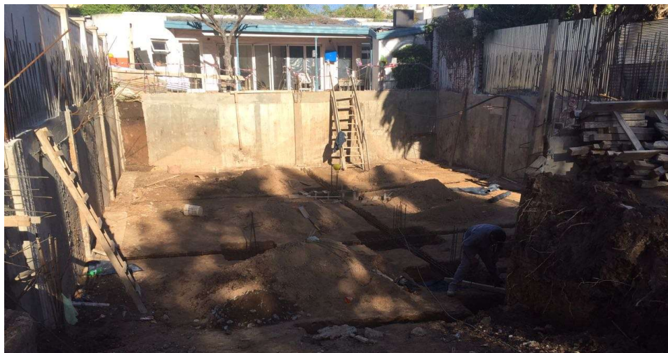
Imagen n°11 - Excavación para bases y vigas de arriostamiento
