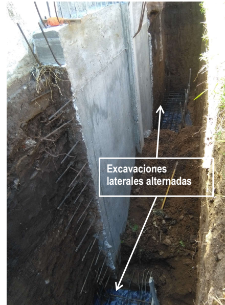
Imagen n°5 - Excavaciones alternadas y zapatas listas para su hormigonado
