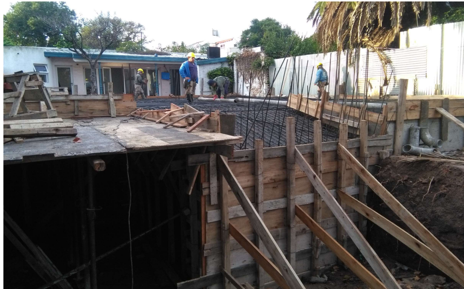
Imagen n°13 - Ejecución de losa s/Subsuelo
