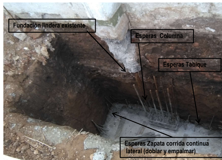
Imagen n°1b - Base excéntrica terminada, se debe proceder cuanto antes al completamiento del tabique vertical, evitando el intercambio de humedad del suelo con el ambiente (desmoronamiento por saturación o sequedad)
