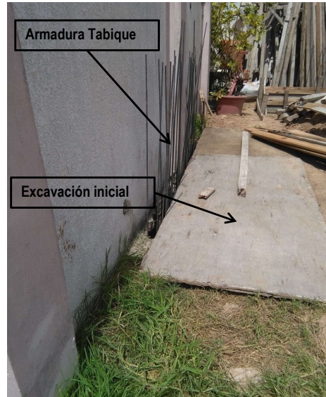
Imagen n°3- Previo al hormigonado, cubrir los pozos por precaución
