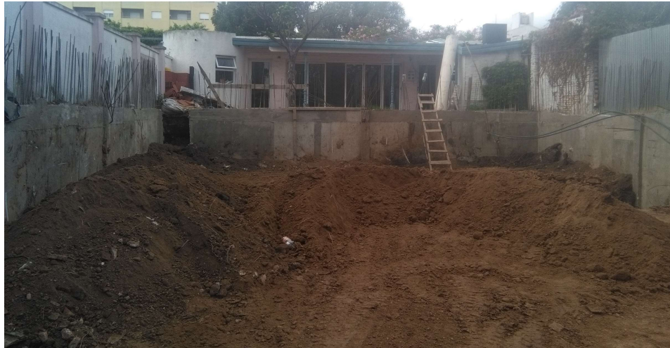
Imagen n°10 - Excavación del TOTAL del volumen central y PARCIAL de los volúmenes perimetrales, confeccionando bermas a mitad de nivel de la excavación de 0.60m a 0.80m, continuando con taludes 1:1 (esta operatoria es un elemento de seguridad adicional de la excavación que prevé la eventual interrupción de la misma por los motivos antes mencionados)
