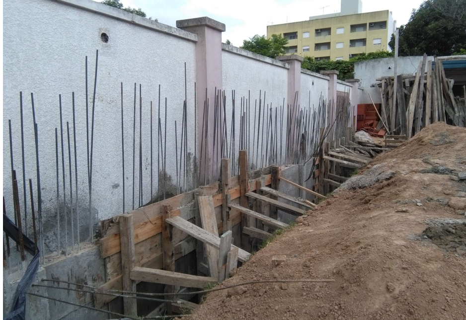
Imagen n°6 - Encofrado y apuntalamiento de tabiques de contención intermedios. La armadura prevista para los empalmes entre los tramos de alternados de zapatas y tabiques verticales garantizan el monolitismo del conjunto en todo su perímetro.
