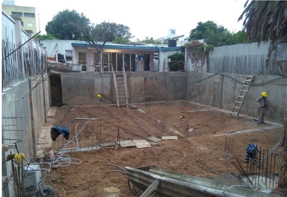
Imagen n°12 - Bases y vigas de arriostramiento terminadas
